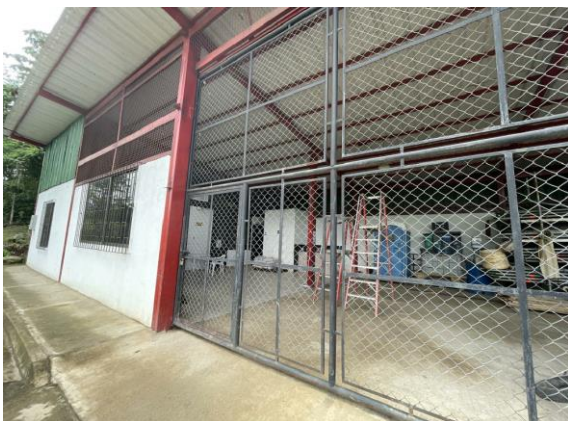
Fotografía 0-6 Bodega de construcción
