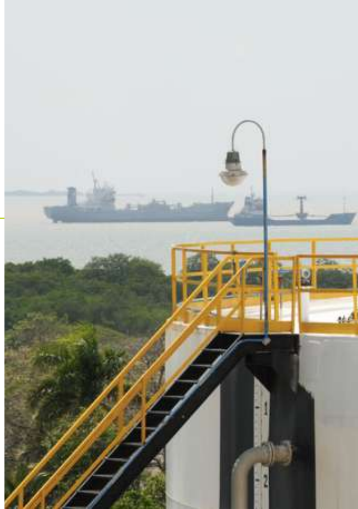
Tanque almacenamiento de producto para exportación, en Cartagena
