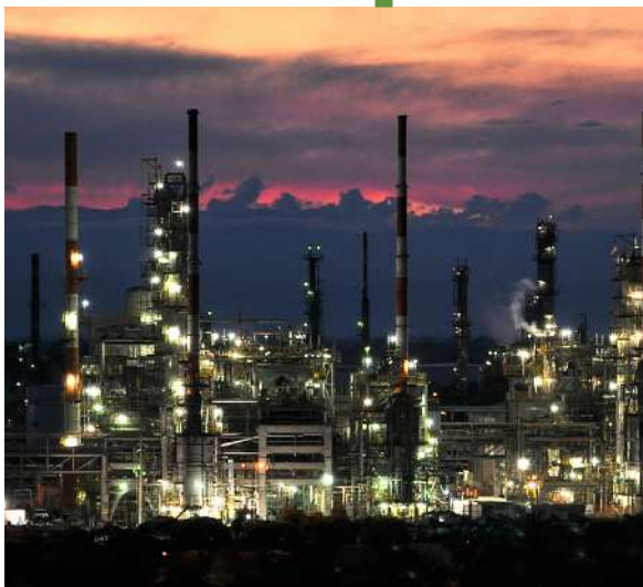
Ecopetrol. Refinería de Barrancabermeja.
