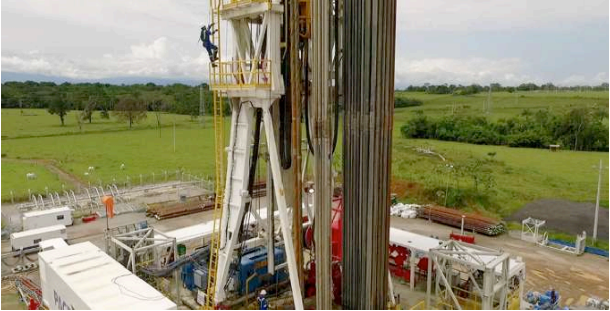
Ecopetrol. Empleados de contratistas cuñeros en taladro, Departamento del Meta.
